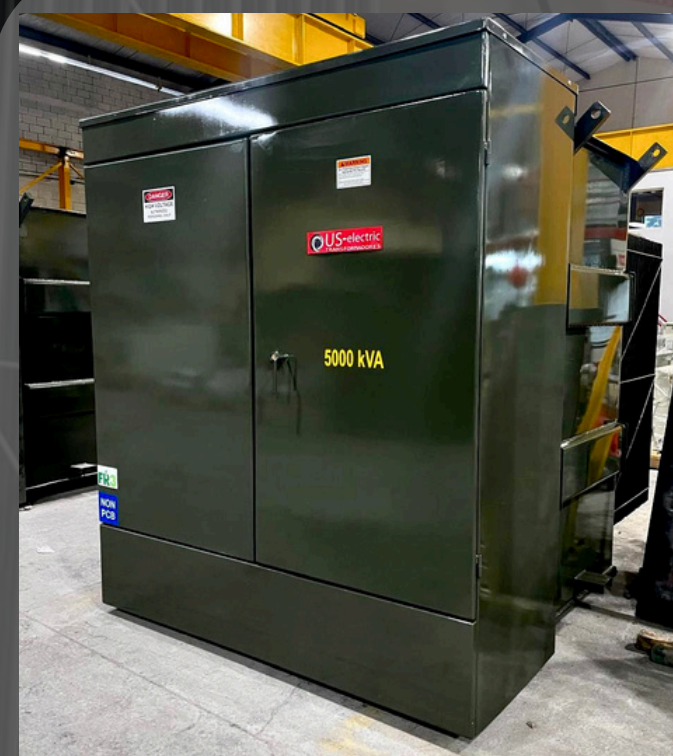
Transformador Pedestal 5000 kVA
